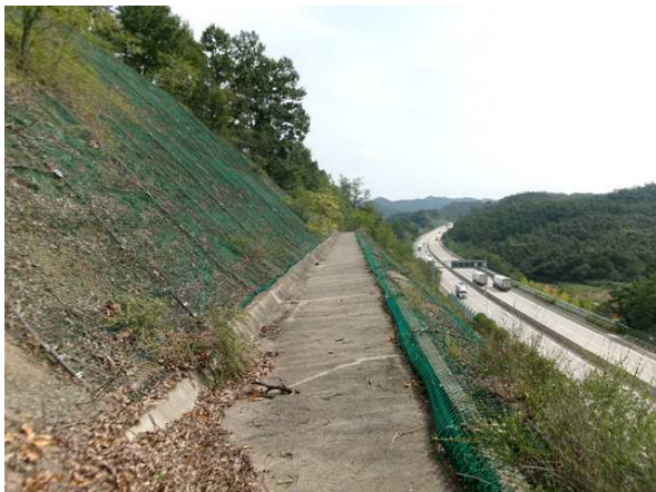
1소단 배수로 전경
