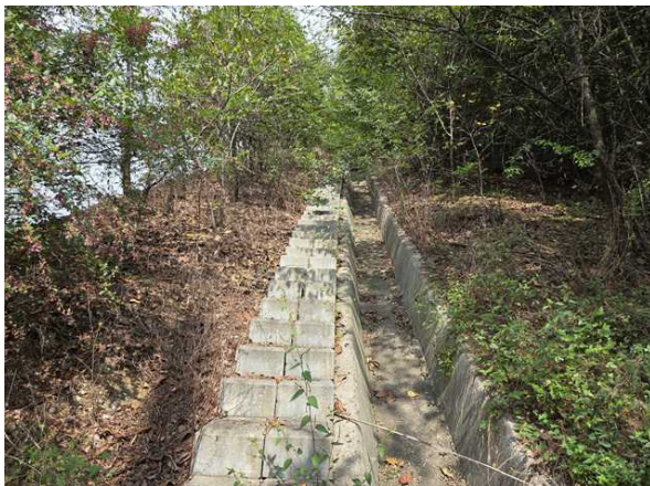
산마루측구, 점검계단 전경
