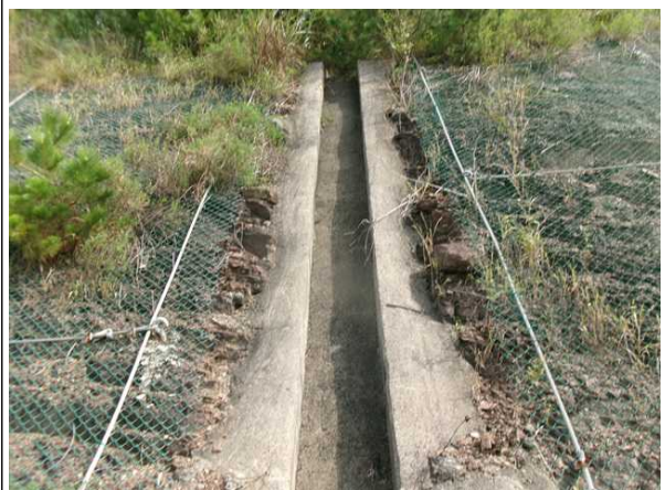
숏크리트, 점검계단 전경
