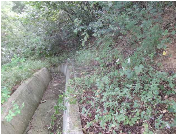
점검계단 및 산마루측구 전경
