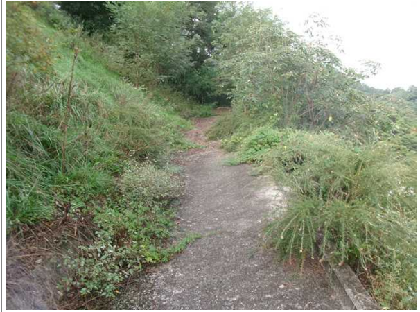
1소단 배수로 전경
