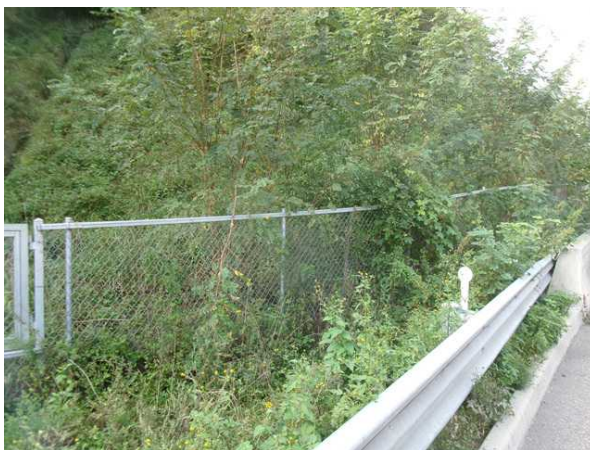
도로부, 야생동물방지울타리 전경
