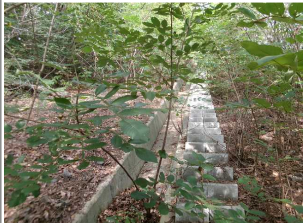
산마루측구, 점검계단 전경
