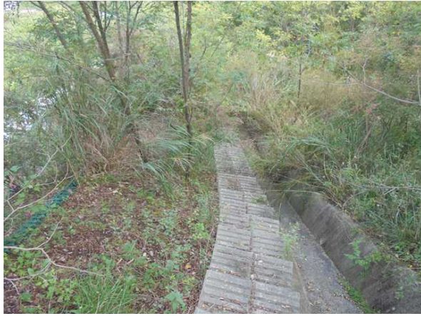
산마루측구, 점검계단 전경
