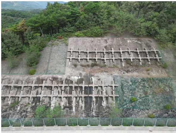
쑏크리트, 격자블럭 전경
