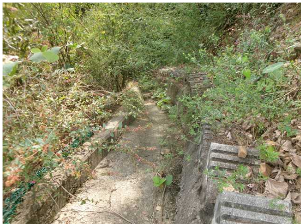
산마루측구, 점검계단 전경
