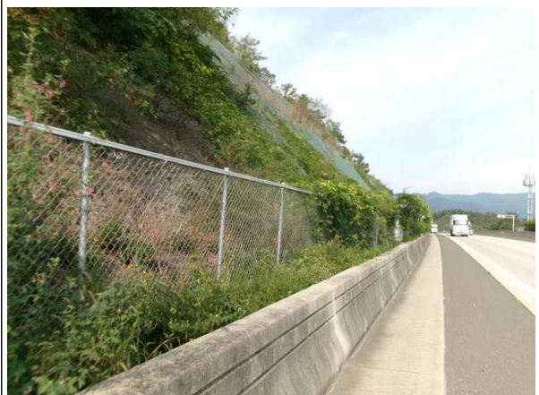
야생동물유도울타리, 도로부 전경
