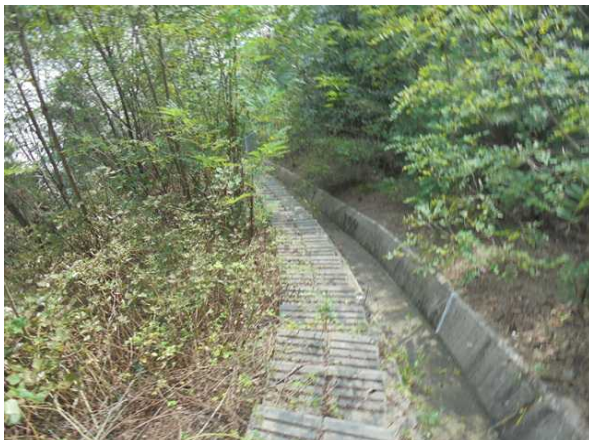
산마루측구, 점점계단 전경
