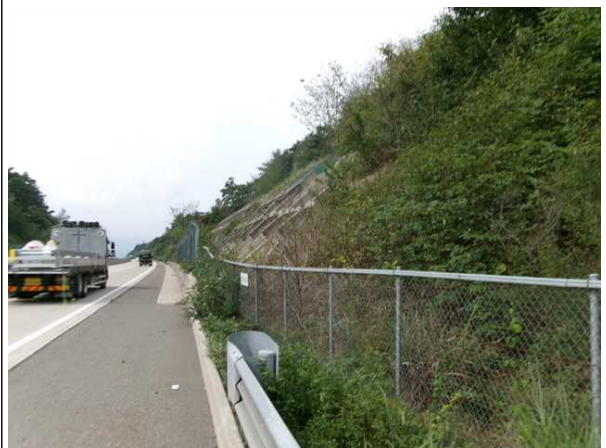
도로부, 야생동물유도울타리 전경
