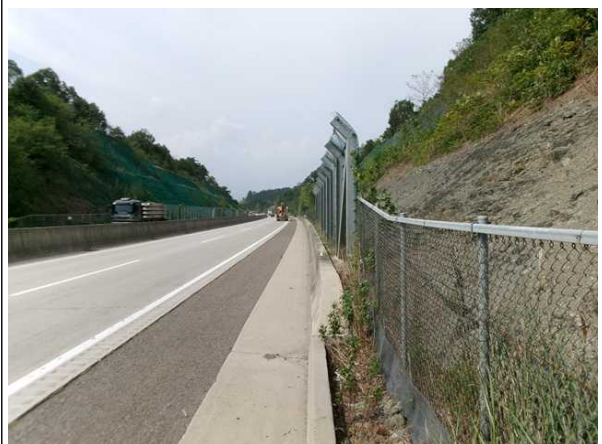
도로부 및 낙석방지울타리 전경
