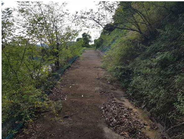
1소단 배수로 전경
