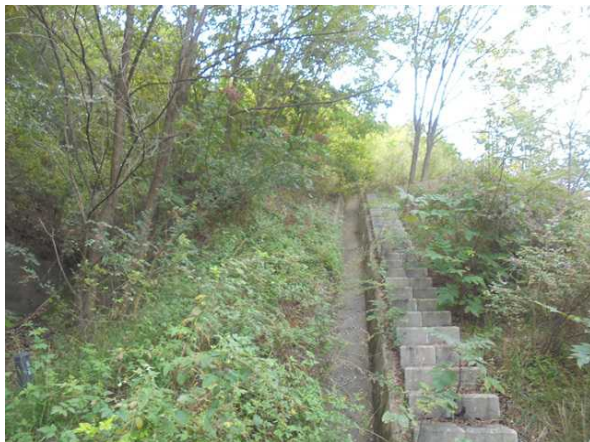
산마루측구, 점검계단 전경
