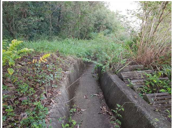
점검계단, 산마루측구 전경
