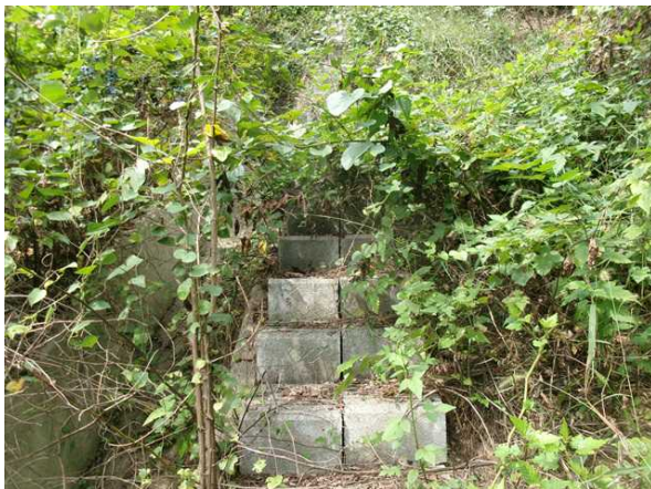
산마루측구, 점검계단 전경
