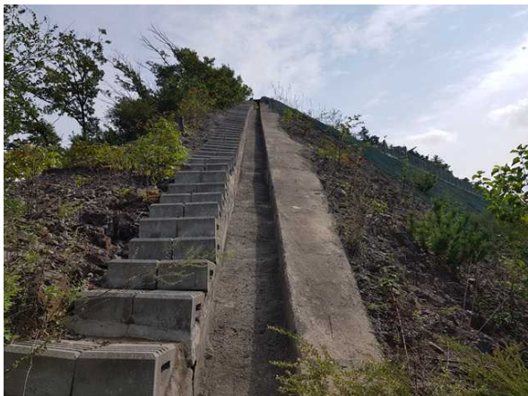
산마루측구, 점검계단 전경
